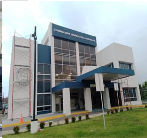
Reparación de la fascia –Bocas del Toro
