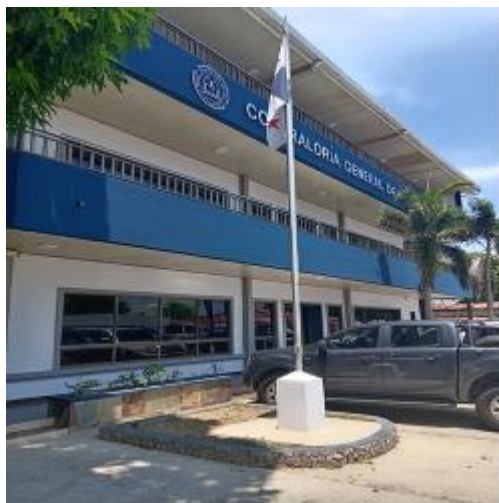
Pintura e Impermeabilización del Edificio Nomé-Coclé
