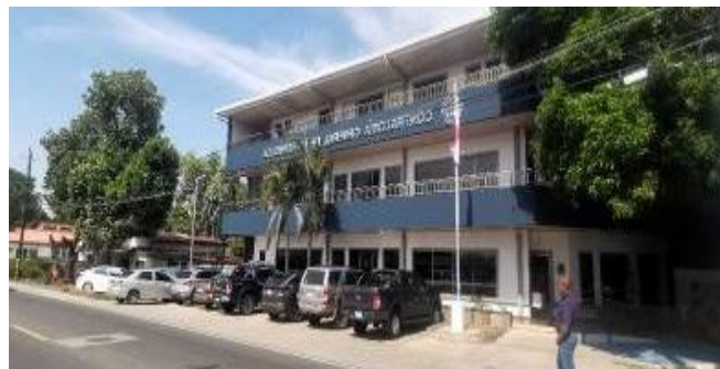
Foto: Servicio de limpieza, reparación de paredes y pintura general de las paredes externas, en la sede provincial de Coclé. Elaborado por la empresa Eiger Business, S. A. Mayo de 2024. Costo B/.39,055.00.
