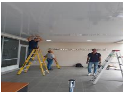
Los Santos: cambio de cielo raso a tipo pvc entrada principal y reparación de la losa
