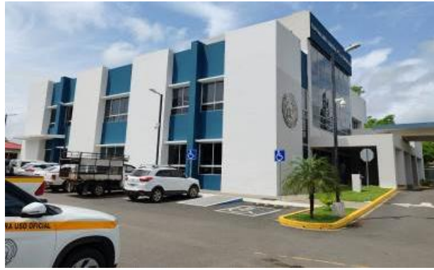
Servicio de limpieza, reparación de paredes y pintura general de las paredes externas, en la sede provincial de Los Santos. Elaborado por la empresa Eiger Business, S. A. Agosto de 2024. Costo B/.48,150.00.
